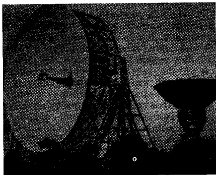
Радиотелескопы обсерватории Джодрелл-Бэнк (Великобритания). Слева — один из крупнейших в мире радиотелескопов с параболической антенной (диаметр 76 м).
